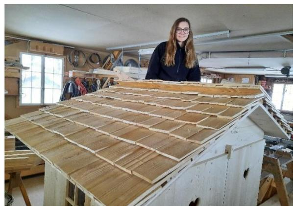
Abbildung 20 fertig geschindeltes Dach, 11.1.2023
