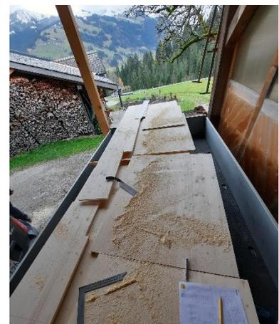
Abbildung 9 zuschneiden der Platten, 19.11.2022
